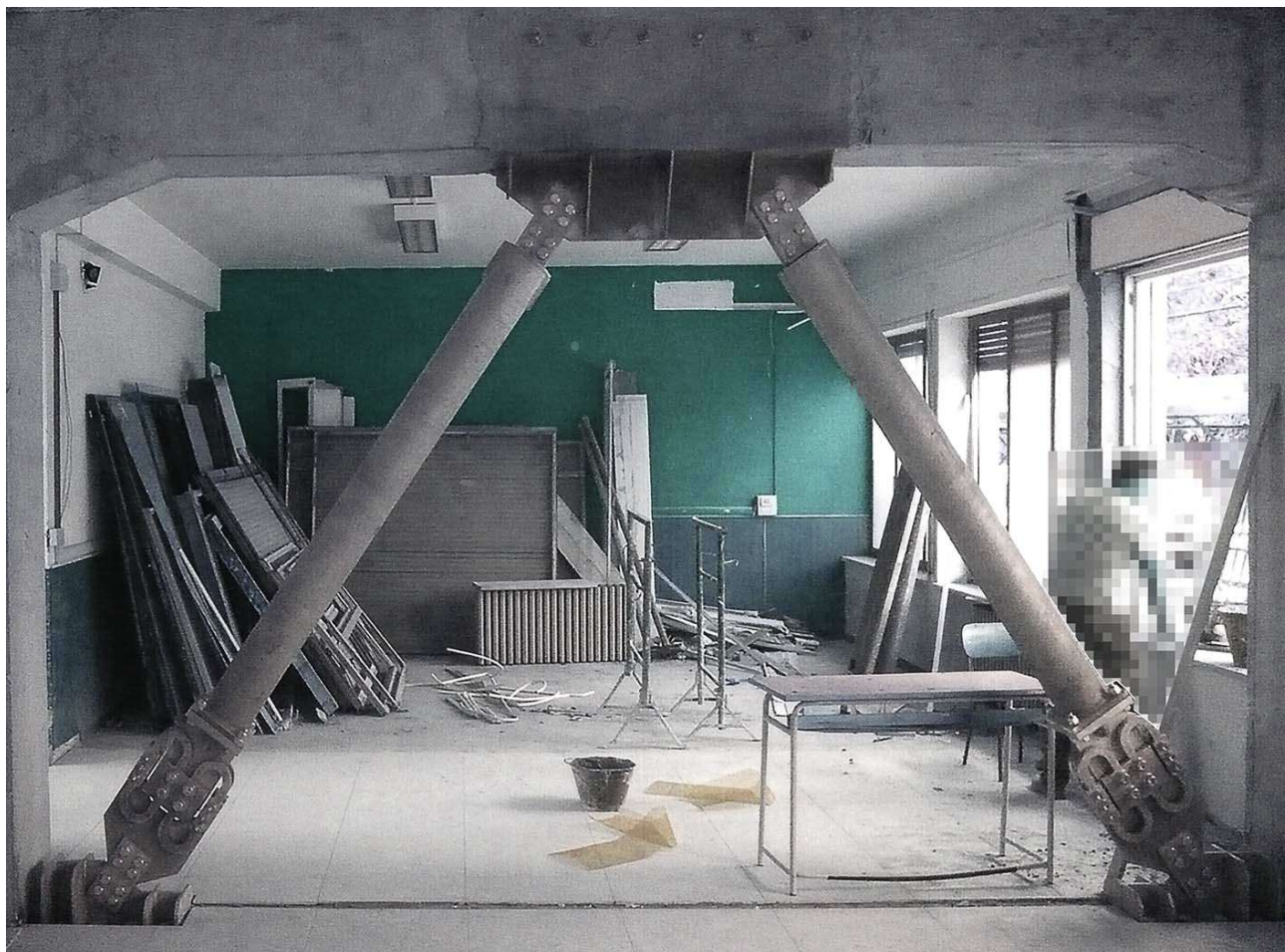
Installazione di controventi dissipativi
